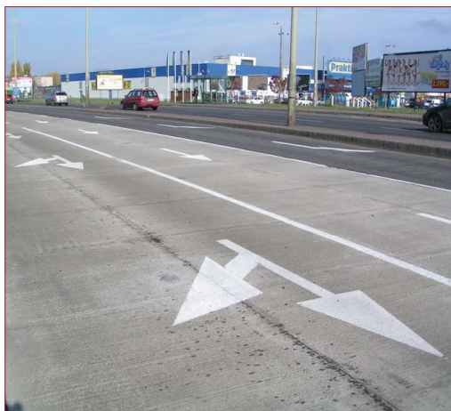
1. ábra Átadás előtt a betonburkolatú kísérleti szakasz
