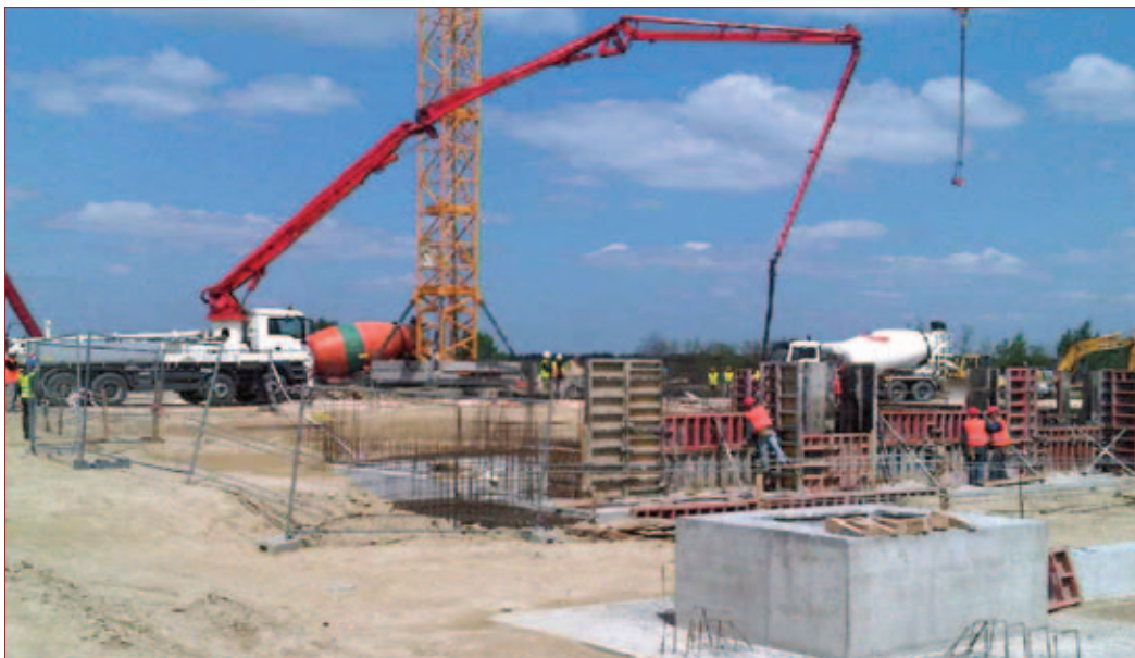
A Holcim beszállítóként vesz részt a 2100 új munkahely megteremtését eredményező beruházásban
