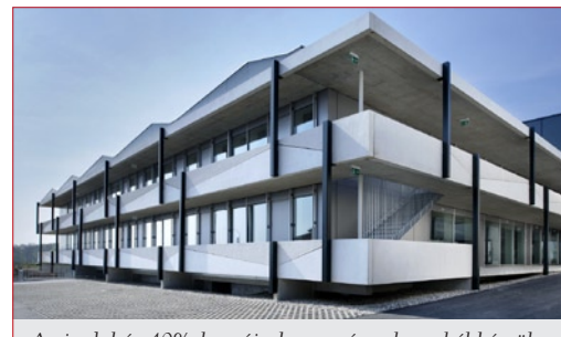
Az irodaház 40%-ban újrahasznosított betonból készült
