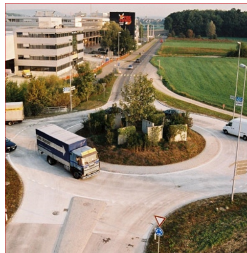
Az első beton körforgalom Svájcban (Forrás: Martin KELLER; International Symposium on Concrete-road Building, Budapest 2004. március 11.)
