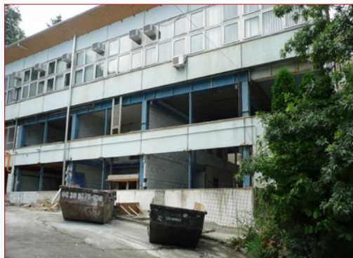
Földszint, galéria szerkezetépítés
