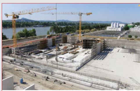
Mélylevegőztető medence építése
