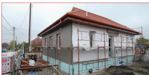
A hőszigetelés felhelyezése és a nyílászárók behelyezése után, megkezdődött a külső színezés
