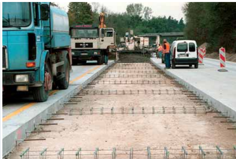
2. ábra: Beton forgalmi sáv dűbelezése és lehorgonyzása útkereszteződésben
