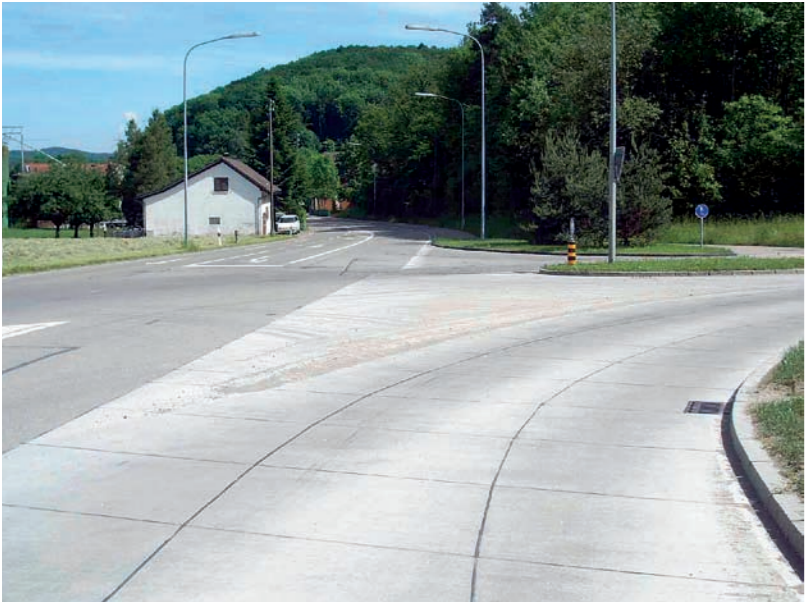
Kereszteződés Glatfeldennél (Zürich kanton)
