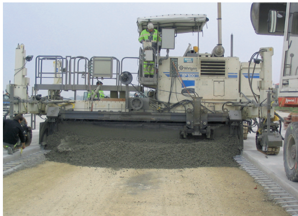
Egy hiányzó sáv betonozása, két, már meglévő közé
