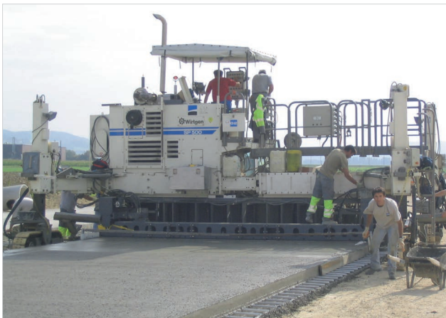
Általános látkép betonozás közben
