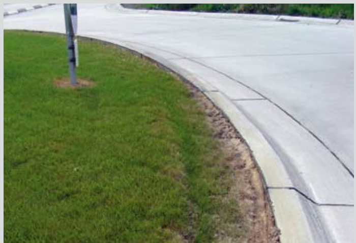
Érintetlen szegély és folyóka, valamint a körforgalmi sziget károsodása (fénykép a szerzötől)
