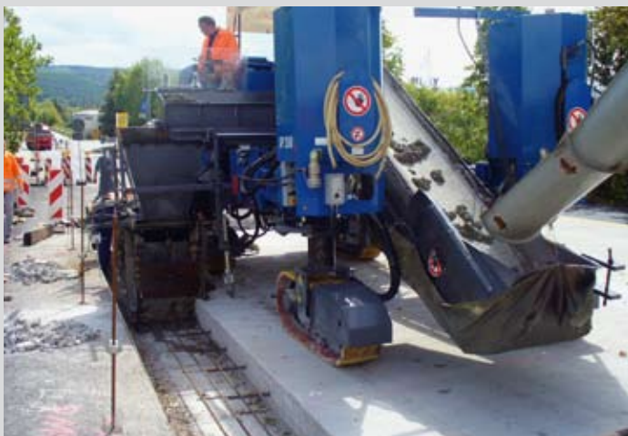
A szegély és a folyóka beépítése Bad Sobernheimben csúszós-salus finiserrel (fénykép: J. Gisdepski)
