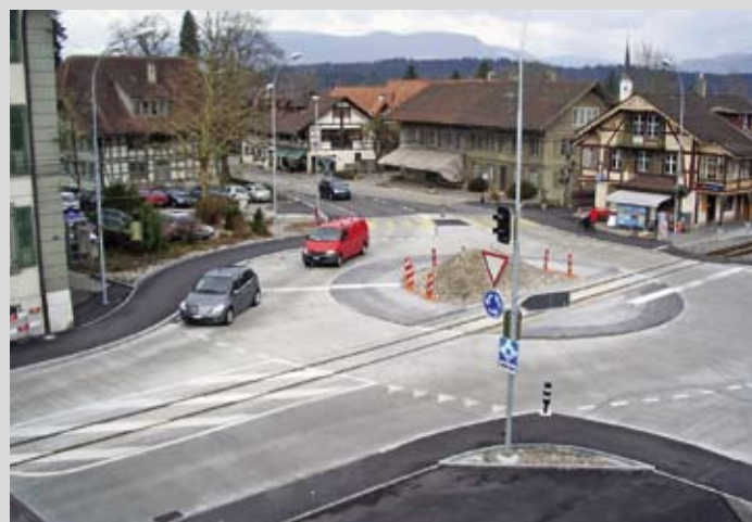
Beton körforgalom Aanwangen központjában vasúti pályával kombinálva, 2007
