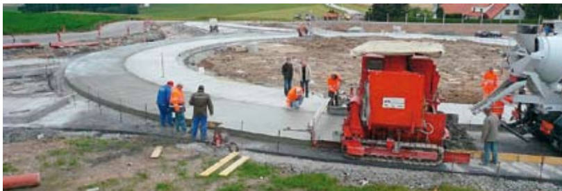
Körforgalom építése Stapfenedtben, Felső-Ausztriában, csúszózsalsal finiserrel (fénykép: Felső-Ausztria tartomány)
