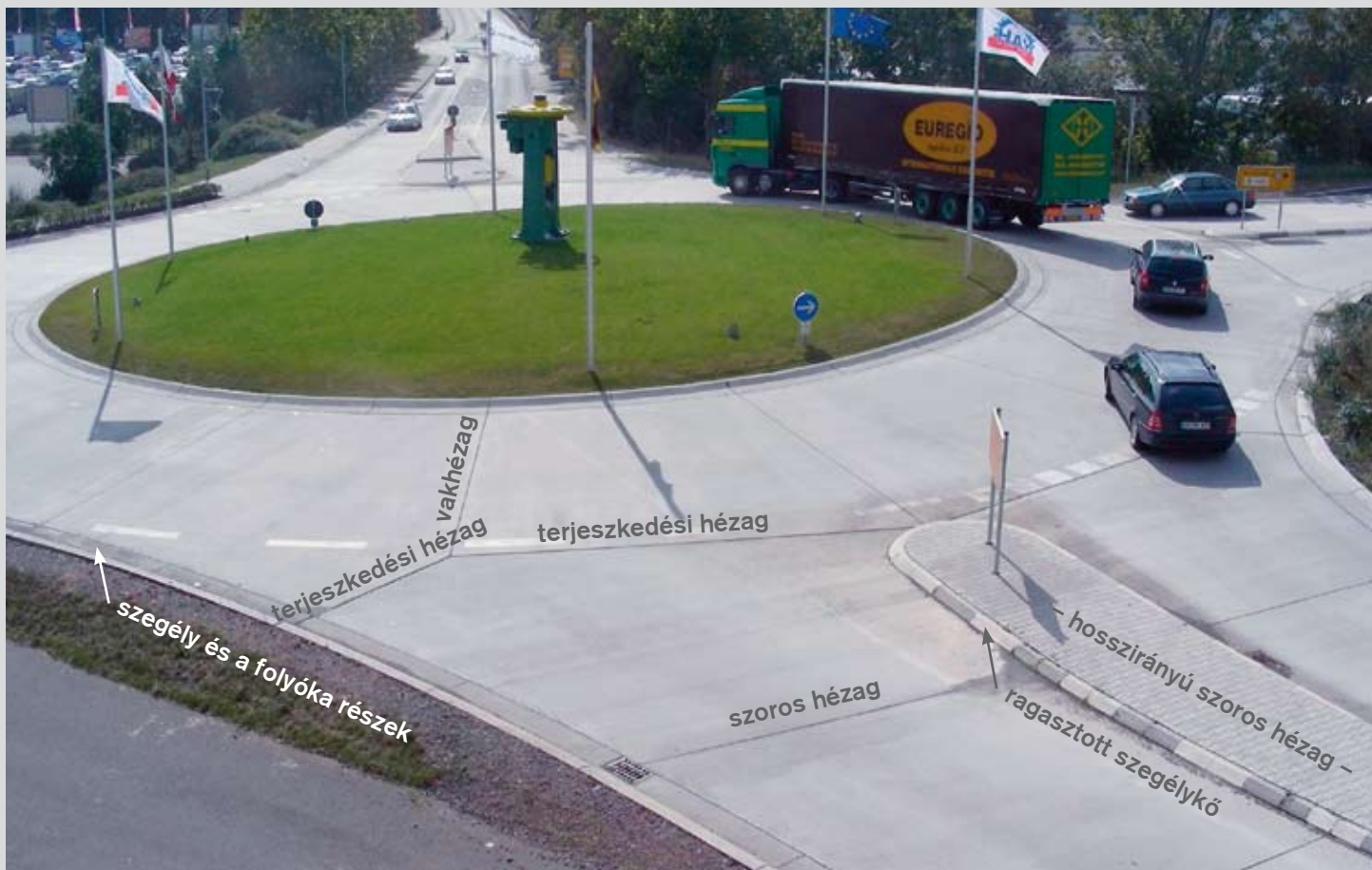
Körforgalom Bad Sobernheimben, 2007. szeptember, hézagkiosztással (fénykép a szerzótől)
