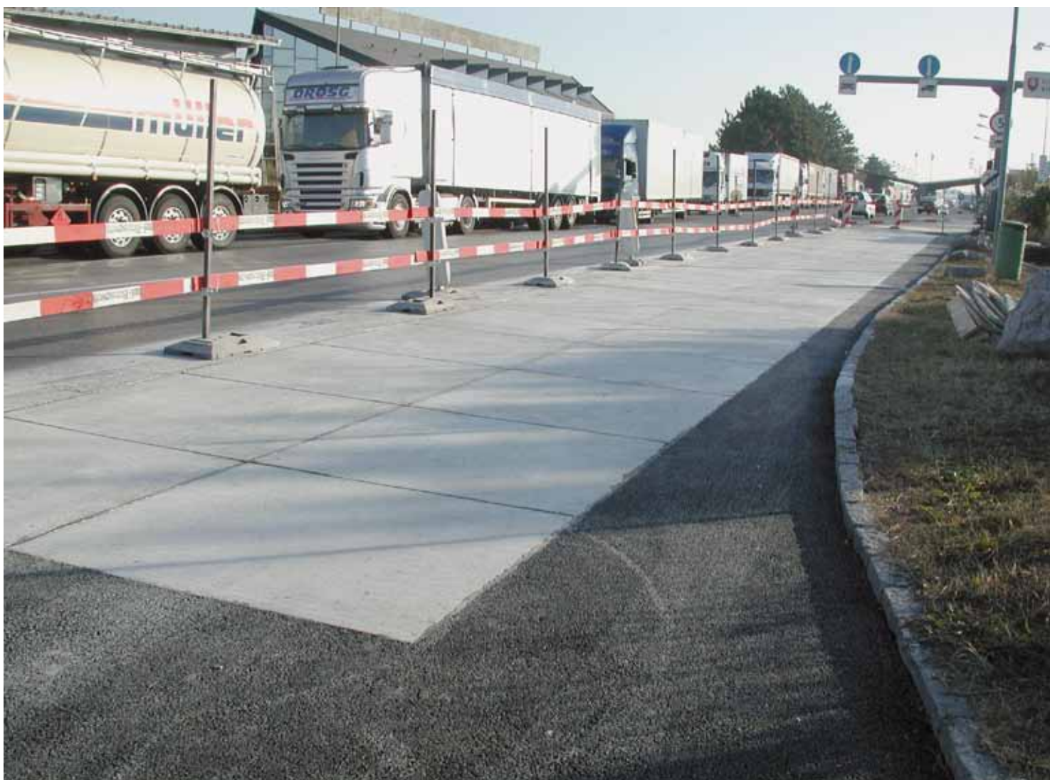
6. kép: (Fehér)betonszönyegezés (white topping), referenciaszakasz Bergnél, Alsó-Ausztria Fotó: VÖZ
