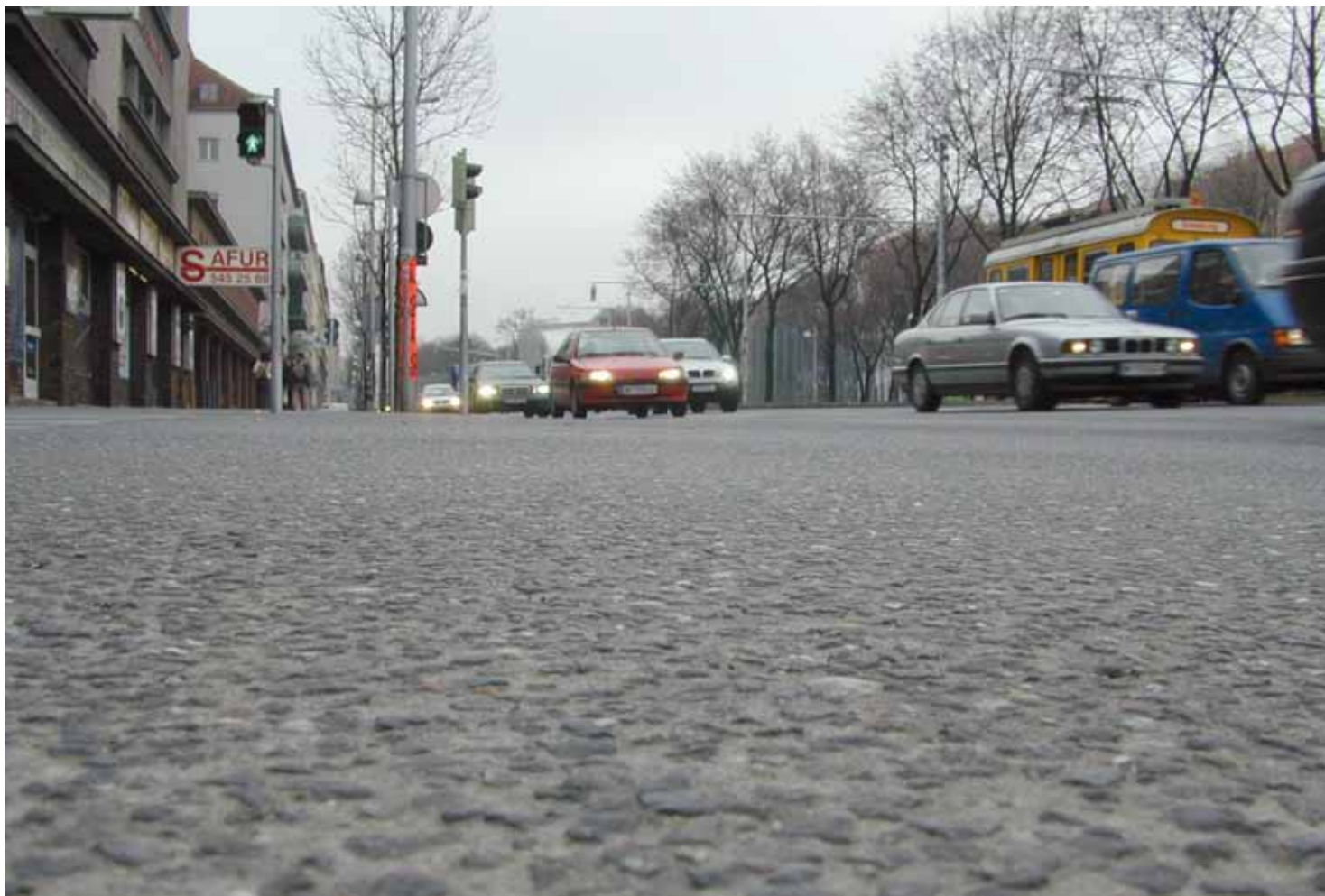
3. kép: Mosottbeton felület, Margareten Gürtel, Bécs, 2007 Fotó: VÖZ
