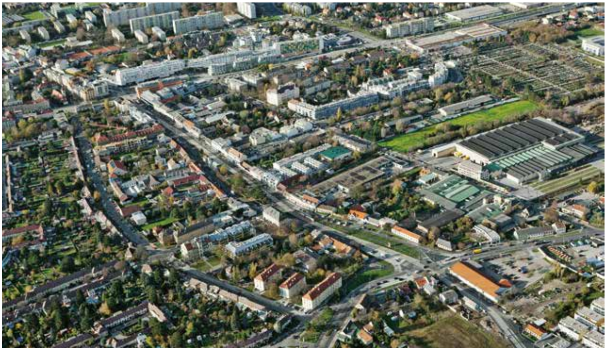
2. ábra: Az 1. sz. építési szakasz a Donaufelder Straße-től Forstnergasseig
