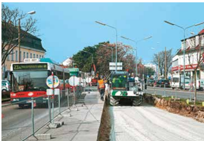
9. ábra: Cementstabilizáció beépítése a Kagraner Platz környékén
