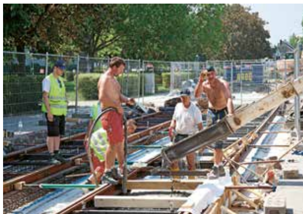
10. ábra: Betonmezők építése
