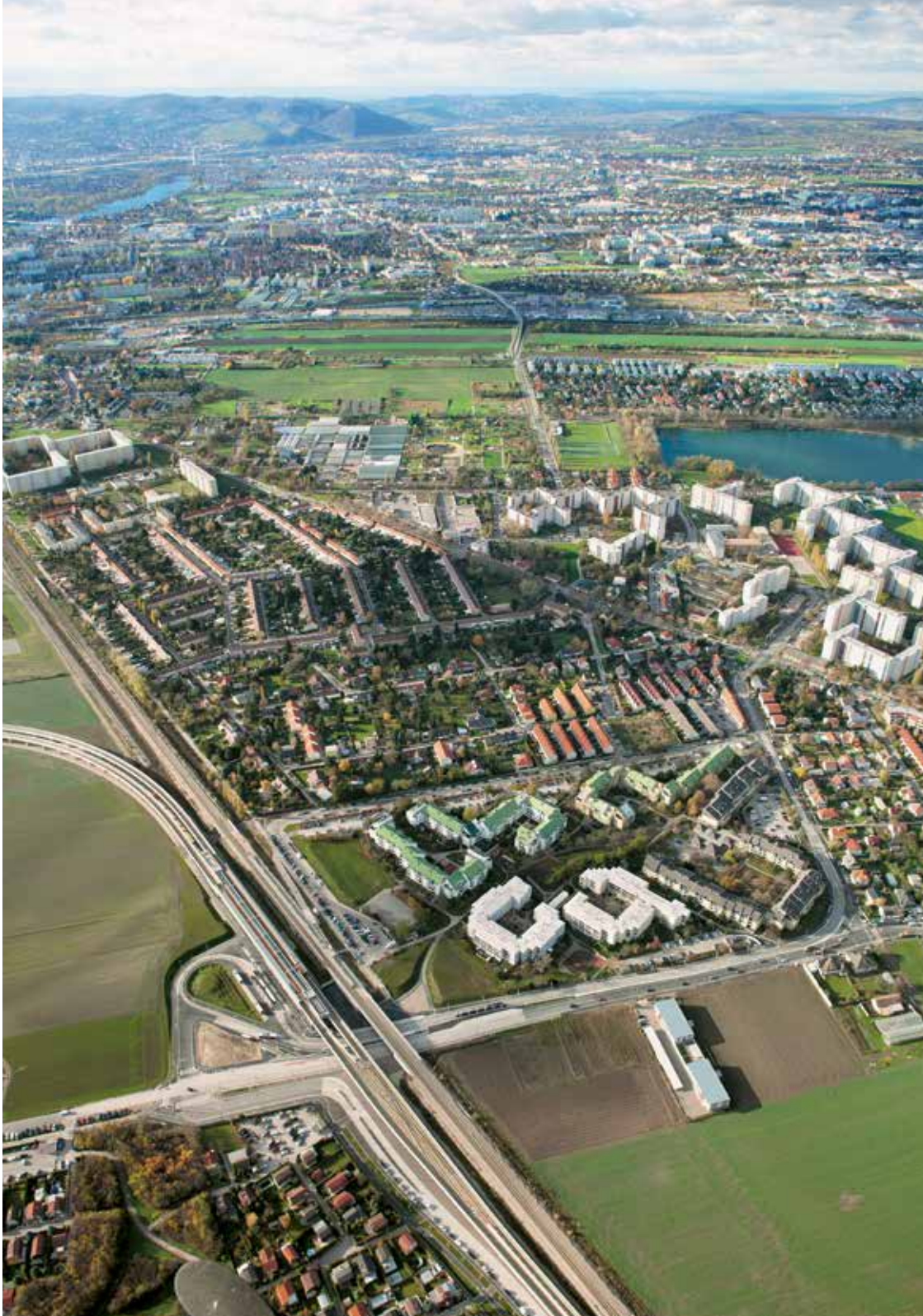
6. ábra: 3.sz. építési szakasz: A hausfeldstraBei fordulóhurok látképe a Kagraneer Platz-ig
