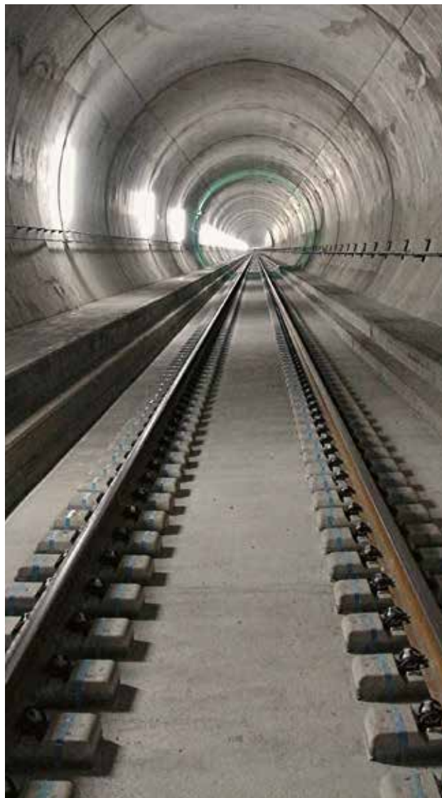
2. ábra: A kész betonlemez vasúti pálya a Faido-Bodio West alagútszakaszon © TTG
