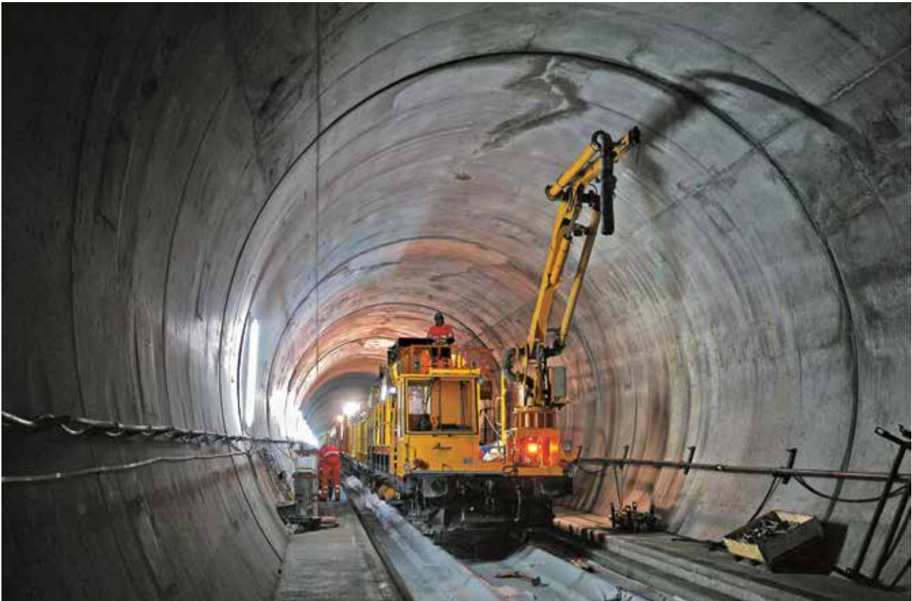
12. ábra: A betonozó vonat fejénél lévő szivattyús kocsi © TTG
