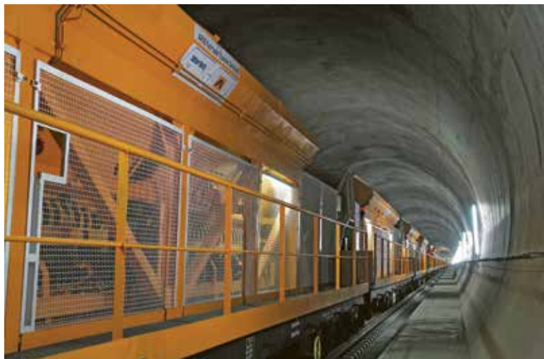
11. ábra: A betonozó vonat adalékanyagok kocsijai © AFTTG
