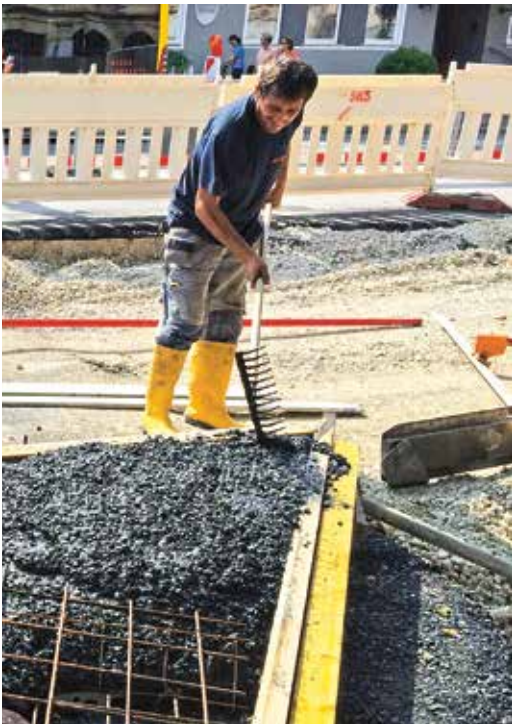
8. ábra: Betonozás
