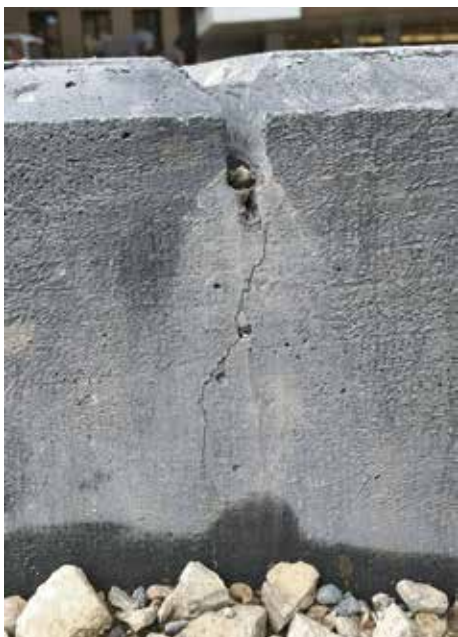
5. ábra: Vakhézag a vápával és a tervezett átrepedéssel
