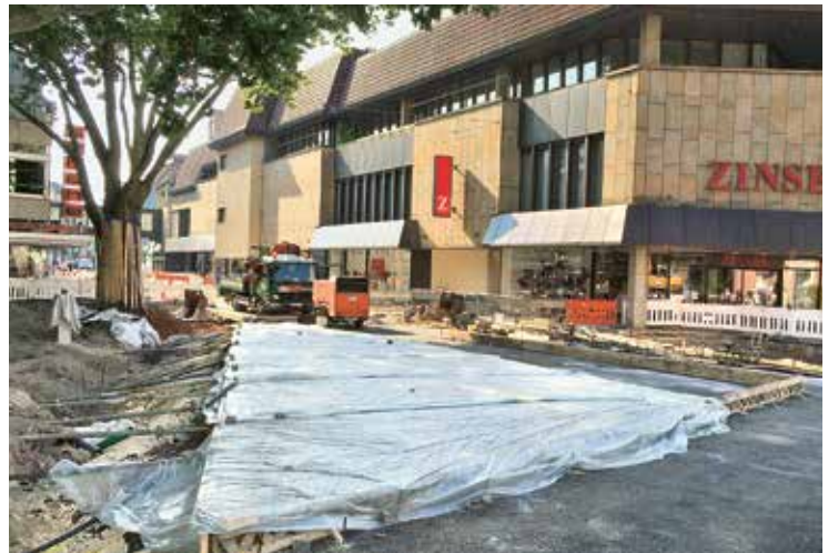
10. ábra: A betonfelületek „becsomagolása” takarófoliába
