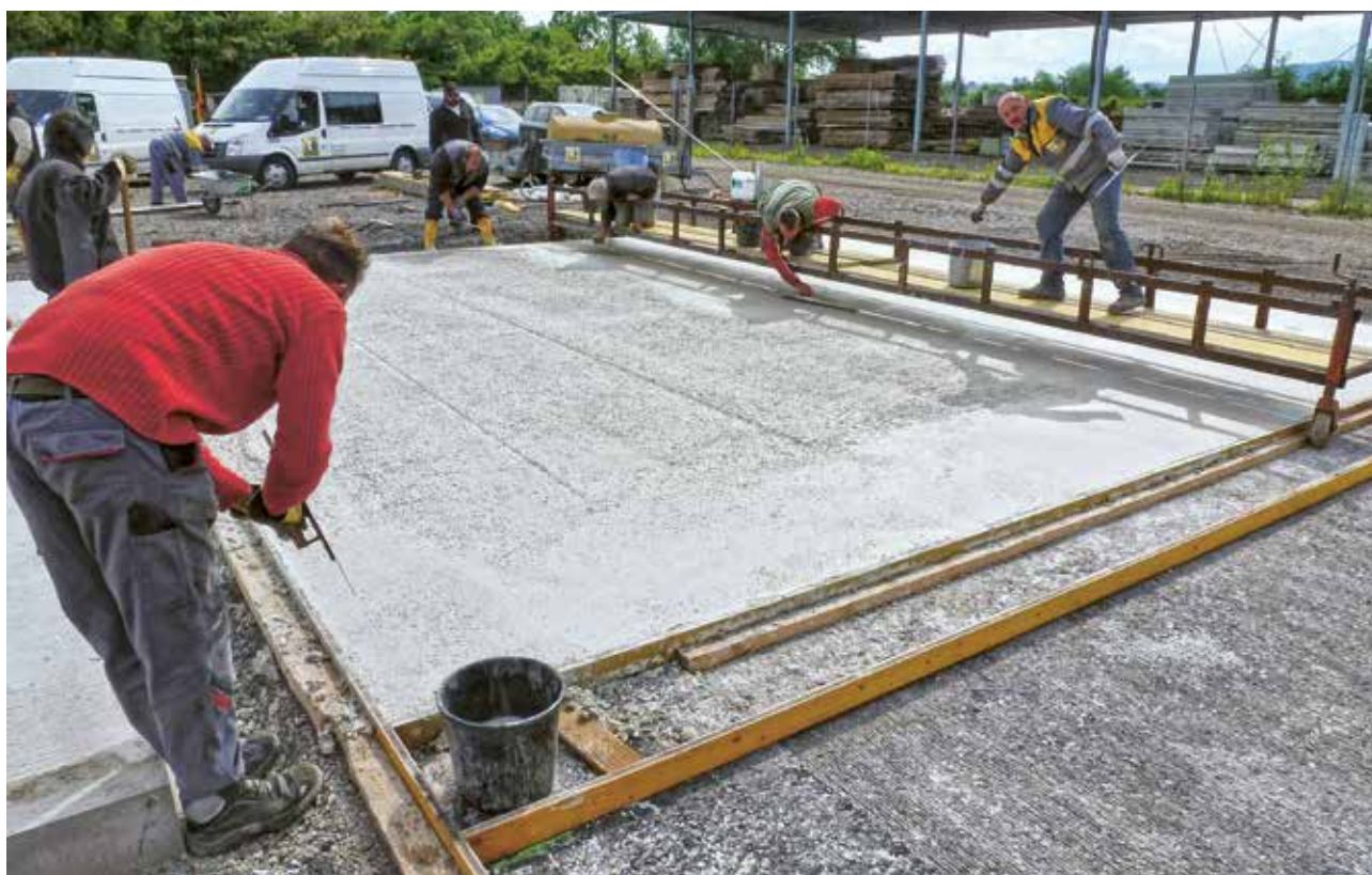
5. ábra: Beton beépítése és felületképzés (seprűvonalak)
