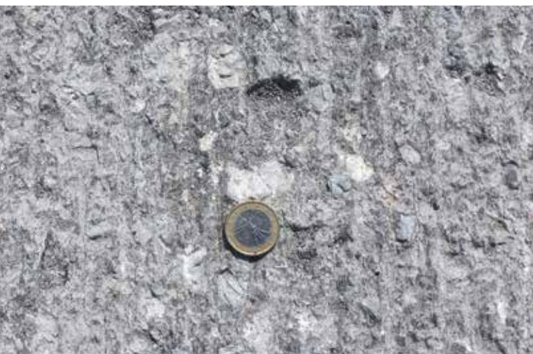
3. ábra: Felső aszfalréteg bemarása
