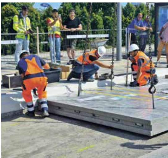
A második előgyártott lemez beemelése a lefolyóakna fölé klasszikus módon (hagyományos drótkötéllal és nagy teherbírású horgonyokkal)
