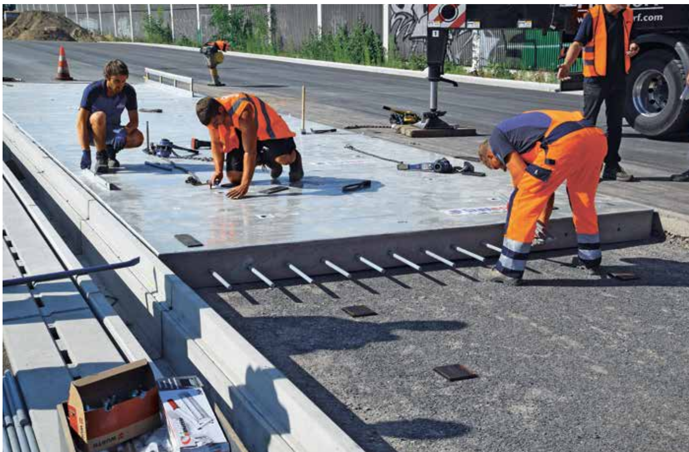
Előregyártott elem a beépített kötőcsapokkal (kötőcsap-csapkamra rendszer)
