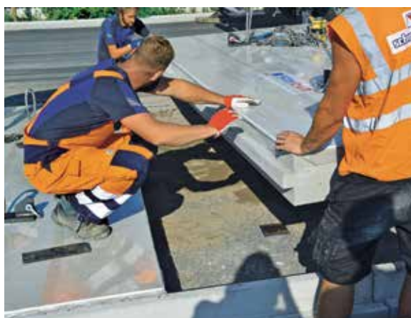
Egy horony-eresztékes kapcsolatú elem behelyezése
