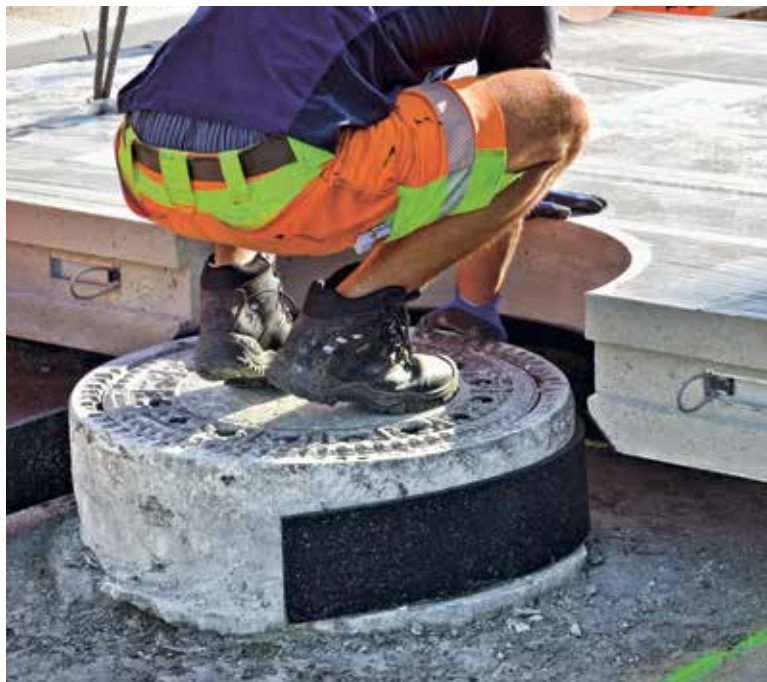
Az első előgyártott elem beépítése az akna fölé
