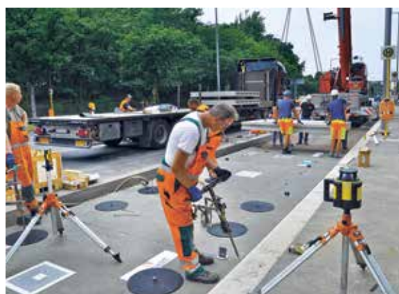
Párhuzamosan folyó munkák egy elembeépítési munkahelyen
