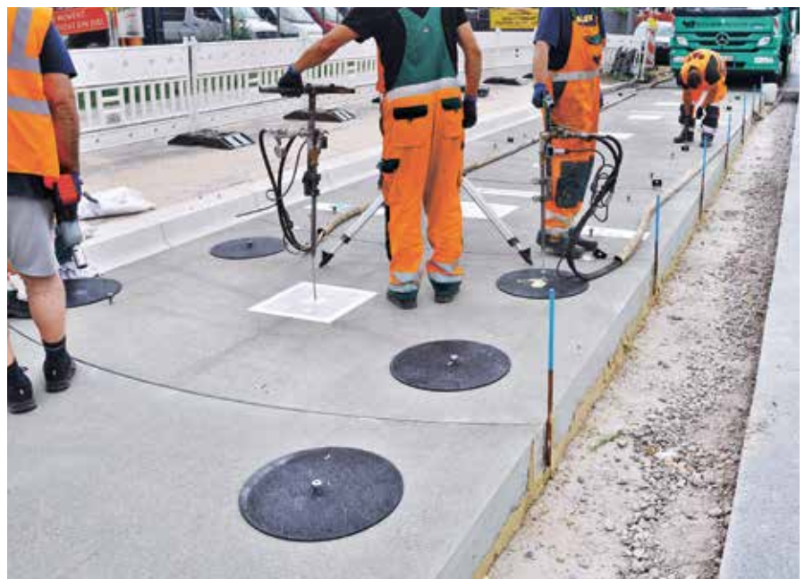
A szilikon alapú gyanta bejuttatása az elemek fektetése és beszabályozása után
