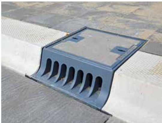
Az első előgyártott elem beépítése az akna fölé
