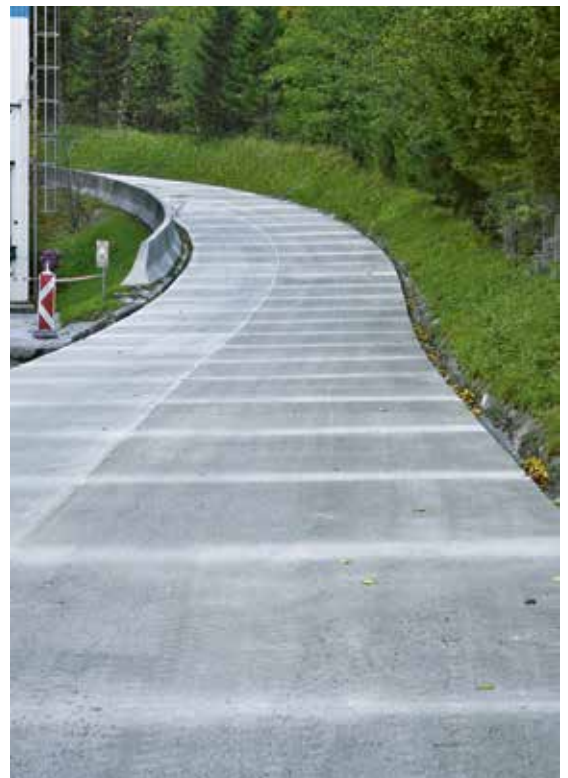
19. ábra: Kézi betonozás az ívek kiszélesítése mentén
