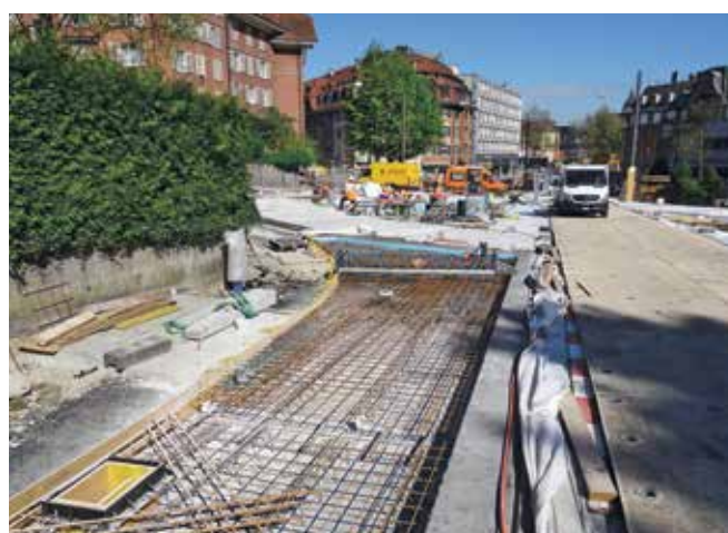
A harmadik ütem betonozása
