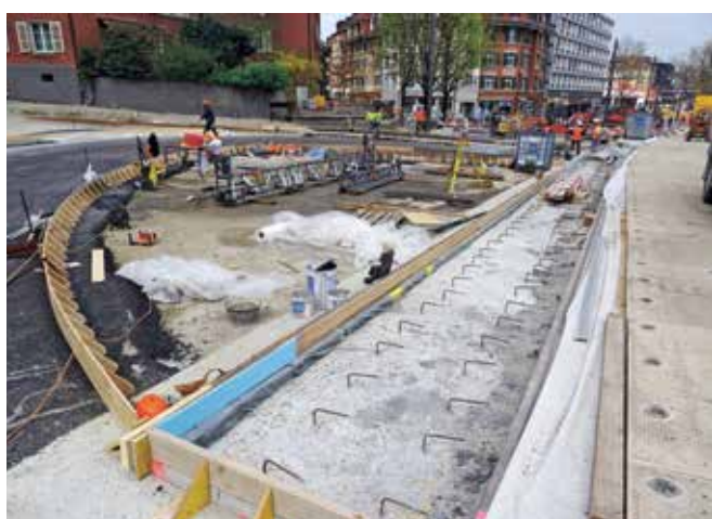
A vágányszegélyek együttdolgozó betonozása
