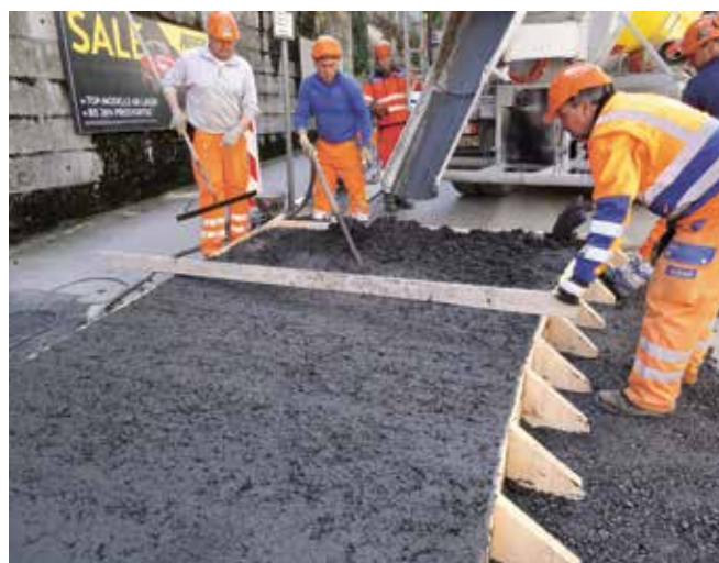
A feketére színezett beton bedolgozása
