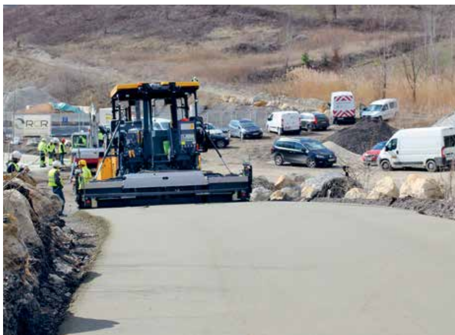
A hengerelt beton beépítése és tömörítése különböző helyzetekben
