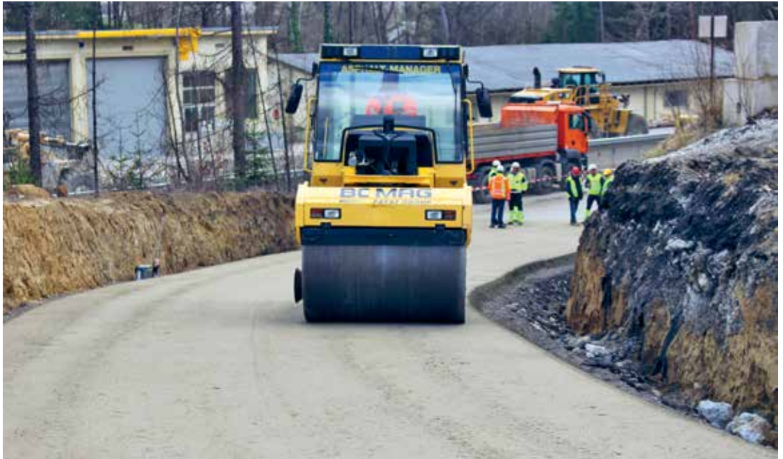
A hengerelt beton beépítése kanyarokban és emelkedő szakaszokon is lehetséges
