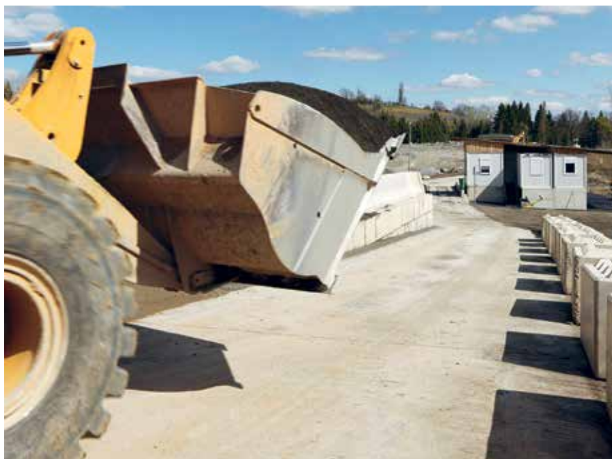
Nehézármű forgalom a hengerelt beton útszakaszon
