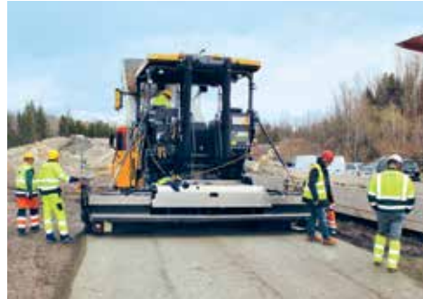
Betonbeépítés láncalpas Volvo-finiserrel. A betonszélesség a gép szélességével azonos.
