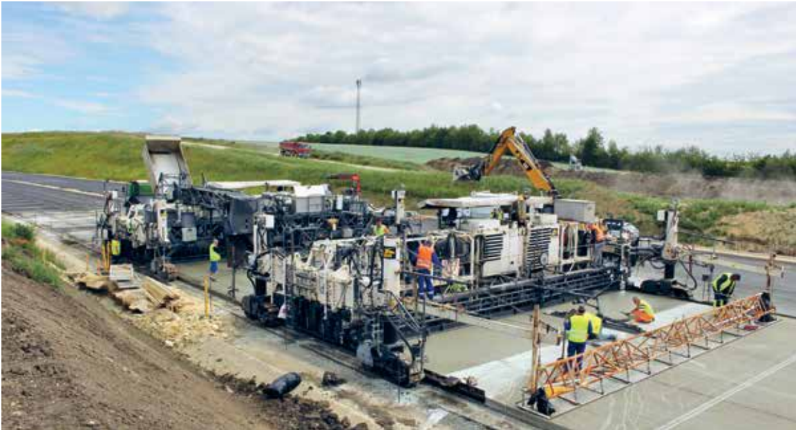
Csúszózsalsus finiser építés közben egy autópályán: szembeforgalmú országutakon való pályaépítéshez az ilyen finiserek általában túl szélesek.
