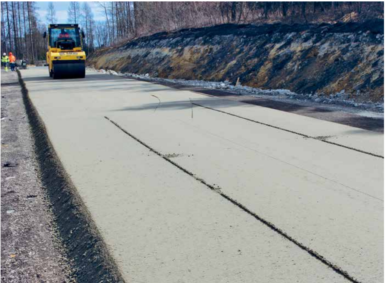
A beton utótömörítése simapalástú hengerrel. Az előtérben látható bordát az utótömörítéskor még elsimítják.
