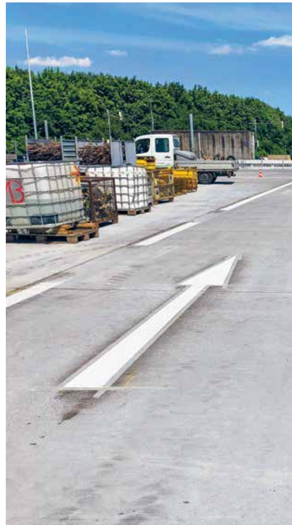
Burkolati jelek készítése
