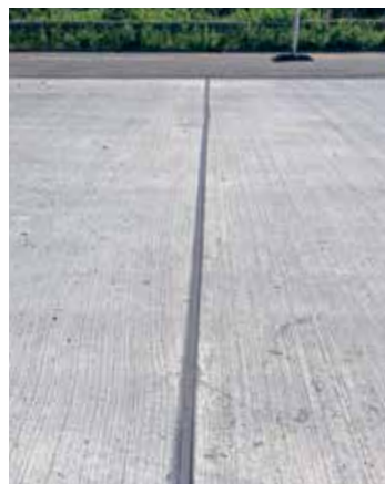
Hézagtömítés poliszulfid alapú két-komponensű hideg tömítőanyaggal
