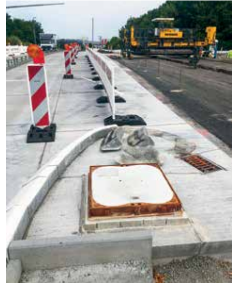
A szegély felragasztása: az elemek közt 3-5 mm-es hézag van
