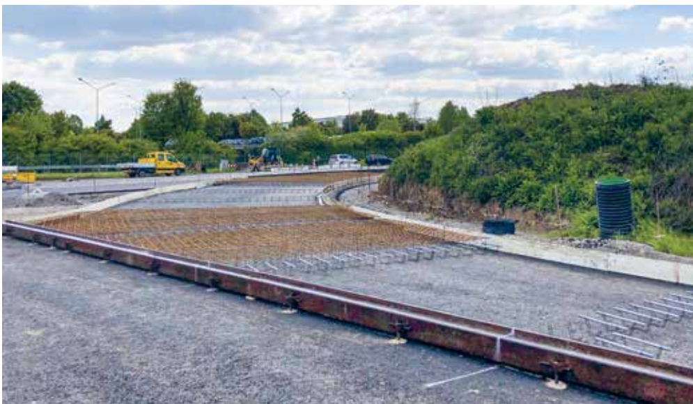
A kosarakon támaszkodó teherátadó vasak („dübelek”) helyzete egy geometriailag kényes, hálószerű szakaszon
