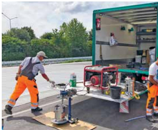
Hézagtömítés poliszulfid alapú két-komponensű hideg tömítőanyaggal
