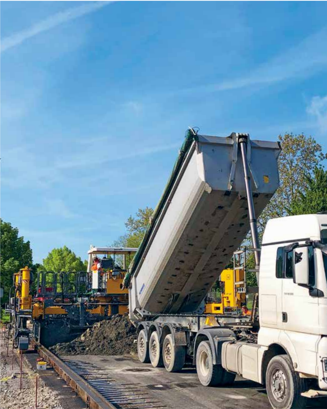
A beton beépítése finiserrel, C1 konzisztencia osztály
