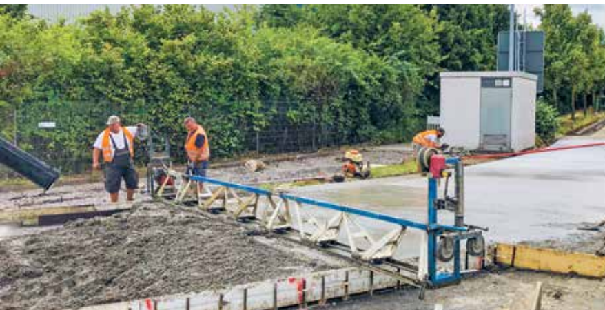
Betonbeépítés vibrogerendával, F3 konzisztencia osztály
