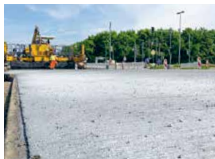
Az utókezelő fehér „Curing” a pályára felszórva
