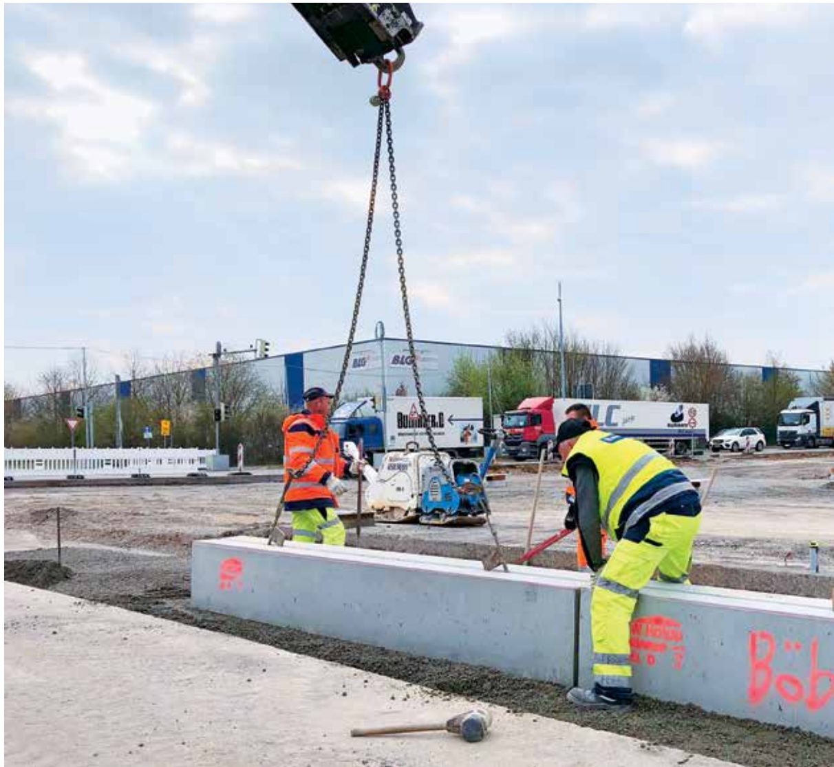
Mélyépítési munkák: új, nagyteljesítményű vízvezetők a pályához
