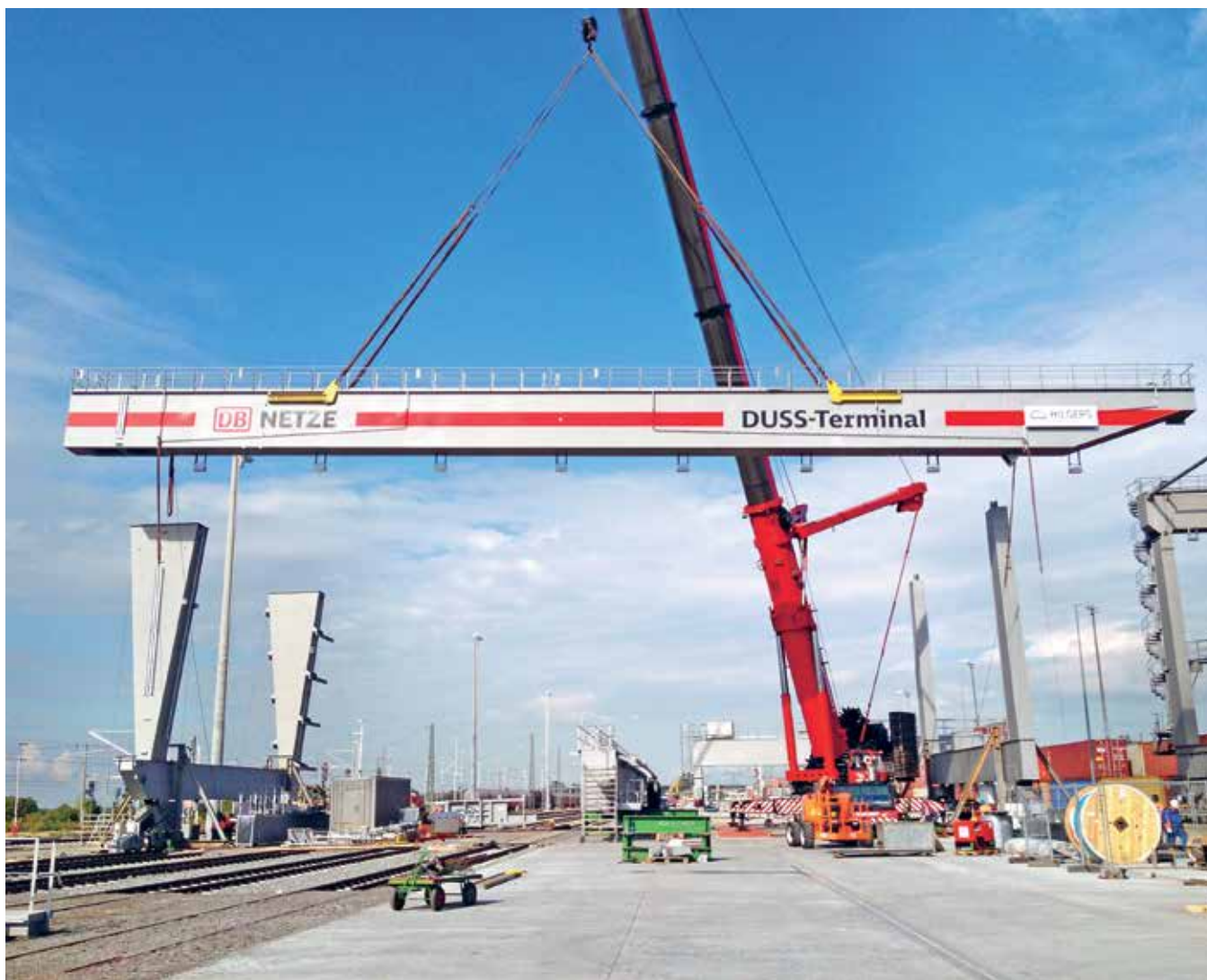
Betonburkolat a portáldaru alatt
