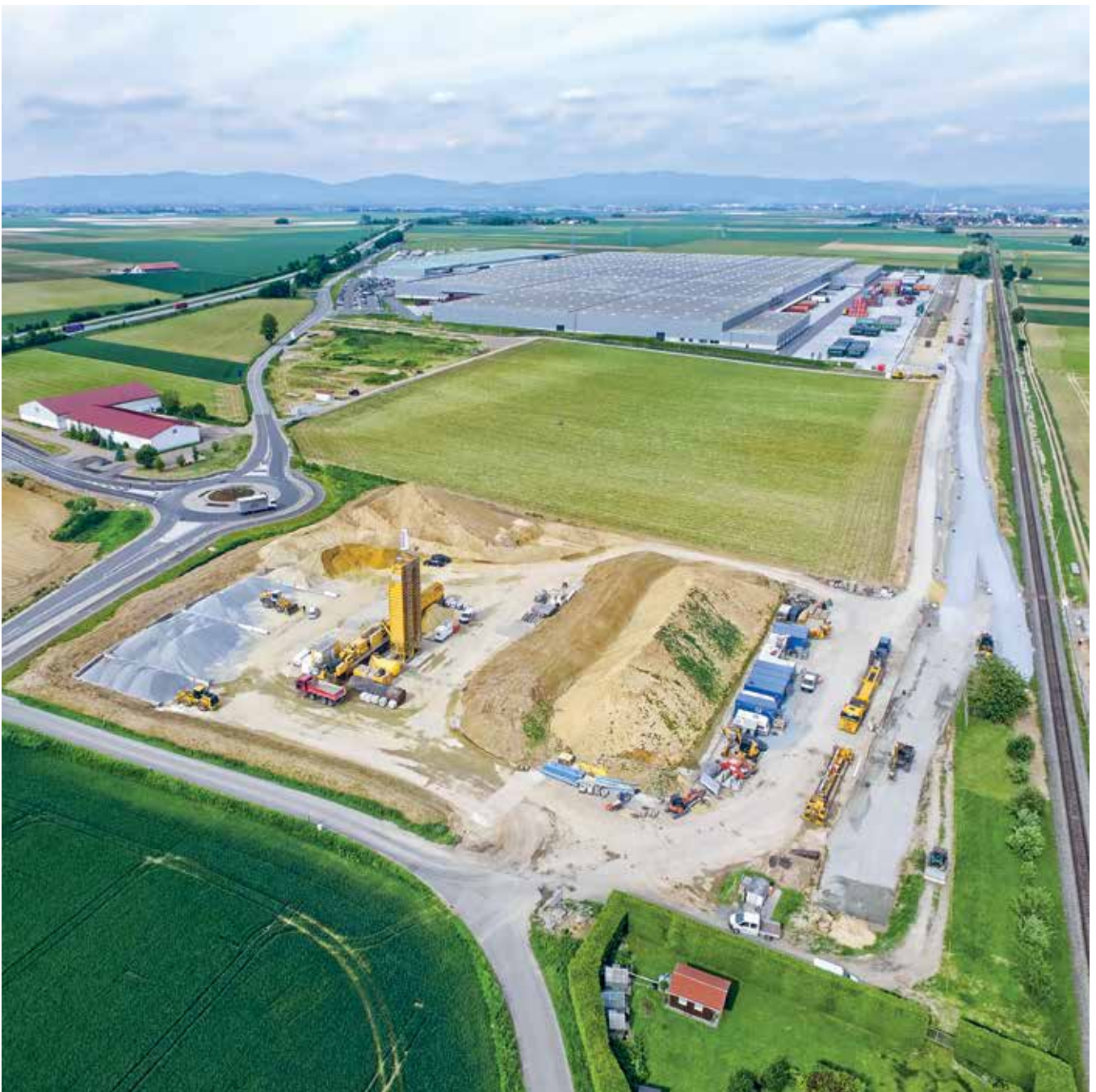
A BMW logisztikai központjának építési helyszíne: előtérben a keverőtelep, háttérben az építési terület
