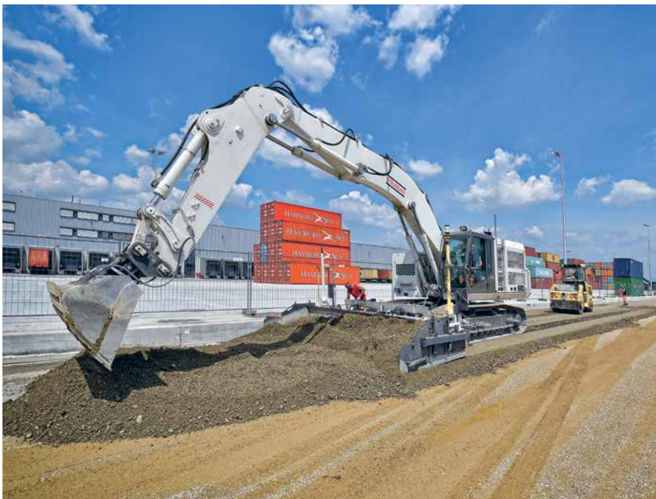
Hidraulikus kötőanyagú burkolataljzat („Ck 1 ”) beépítés
