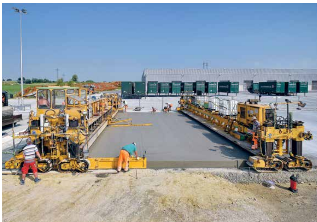
A betonburkolat beépítése
