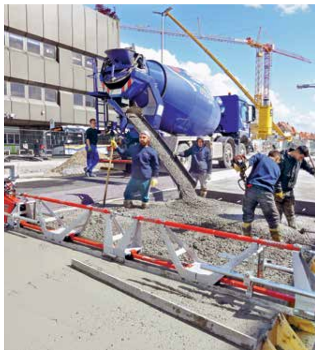
A beton bedolgozása csúszda és vibrohenger segítségével
