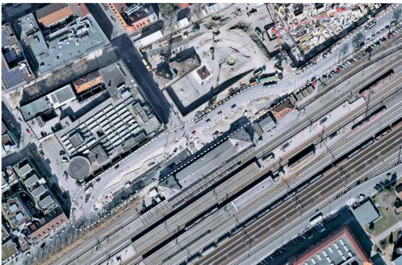
Légi felvétel az átépítés közben. A szaggatott vonallal körülhatárolt építési területen alkalmaztak beton pályaburkolatot.
