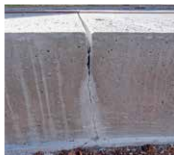
A műszakilag elvárt zsugorodási átrepedés a pályalemezben a vakhézag alatt
