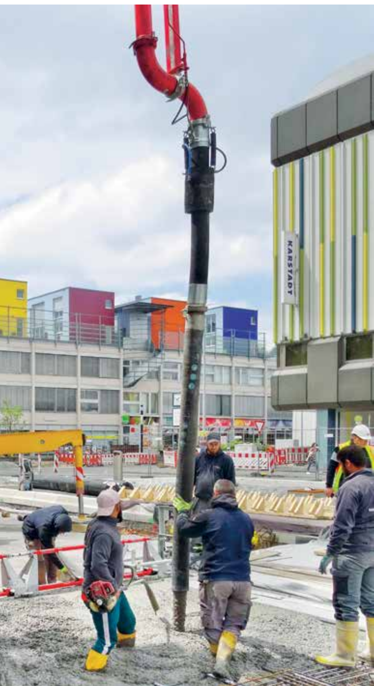
A beton bedolgozása csúszda és vibrohenger segítségével
