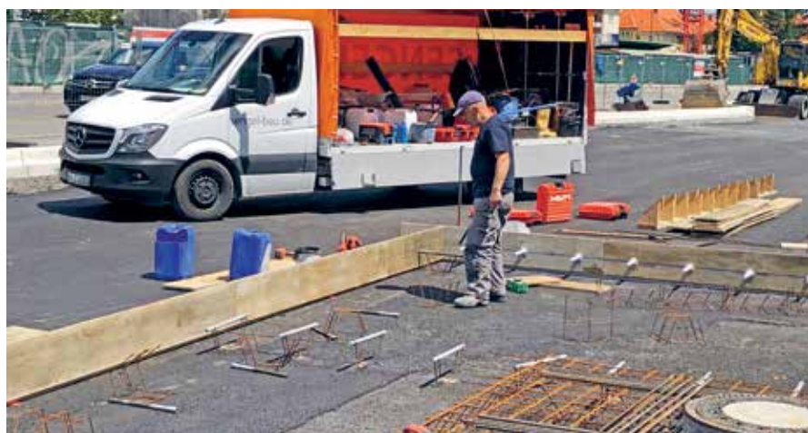
Hézagok/horgonyok/aszfalt alaprétteg (ATS). Vasalás és táglási hézag.
