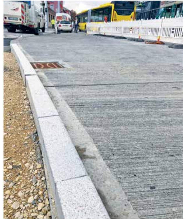
Ragasztott szegély a sörrelt szórt/fúvott (durvított) betonfelületen
