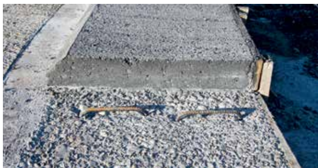
Járható belső gyűrű (körforgalomhoz, német: Schrammbord, lásd még a rajzot jobbra)
