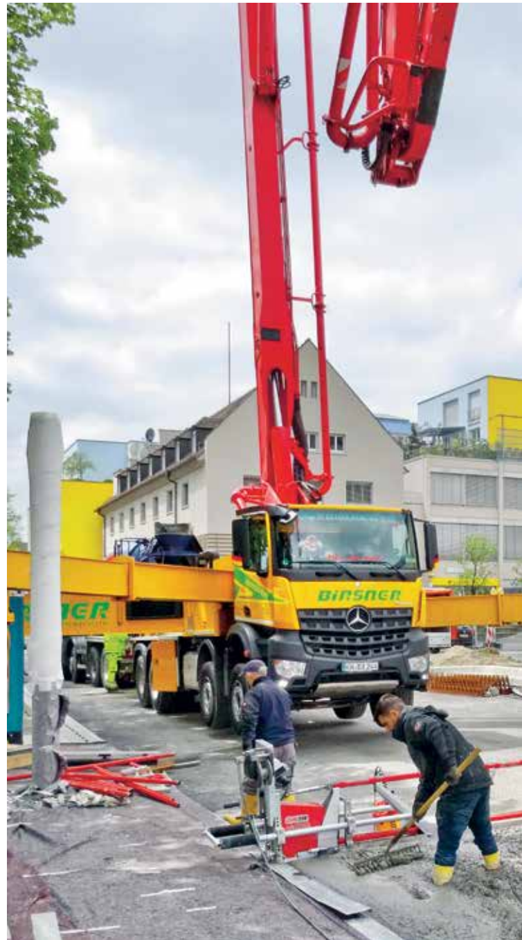
Betonbedolgozás szivattyúval
