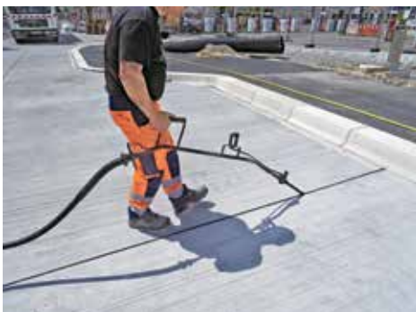
Hézagkiöntés forró, N2 típusú bitumennel
