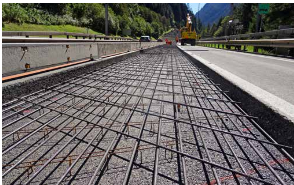
A hossz- és keresztvasalás készre szerelve az ACF 22 jelű aszfalt burkolat alapon (8 cm)
