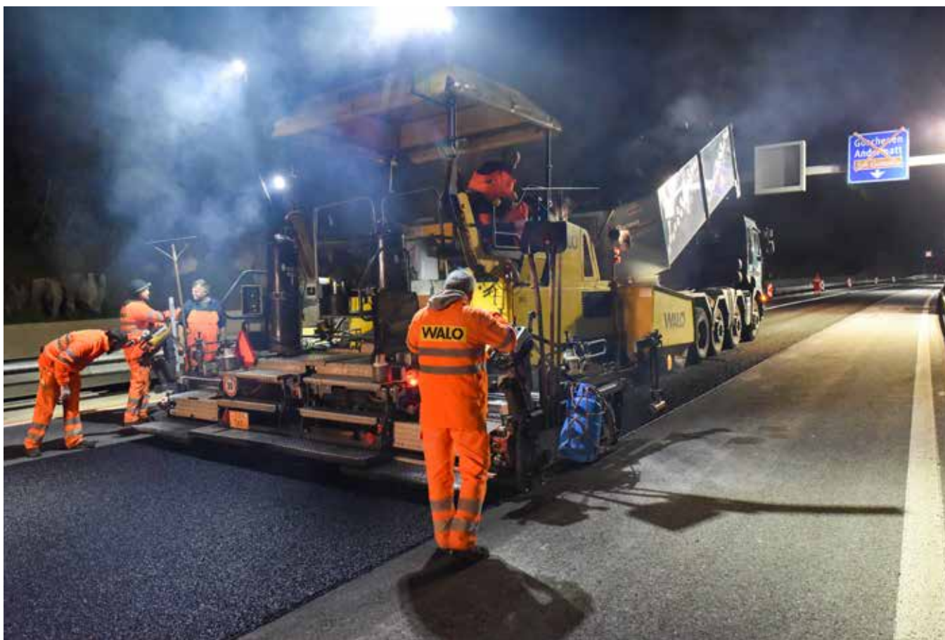
Az „SDA 6-12”-es kéreg- aszfalt készítése, 3 cm
