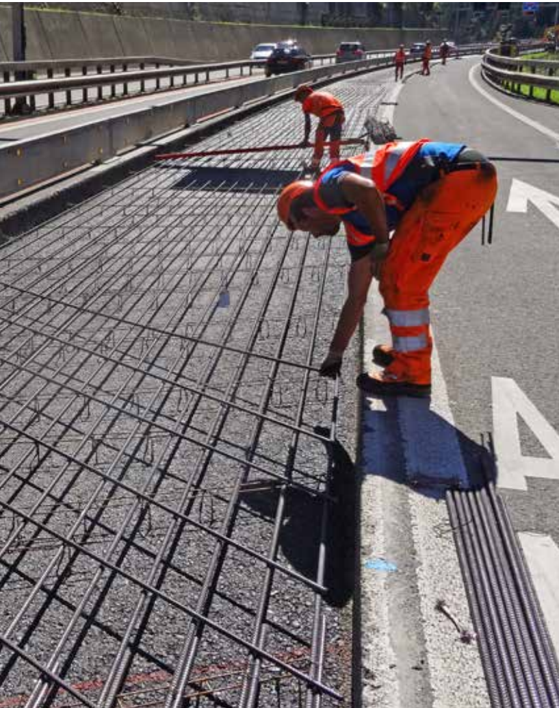
A 60°-os ferdeségű keresztvasak szerelése, jobbra a lehajtóág látszik
