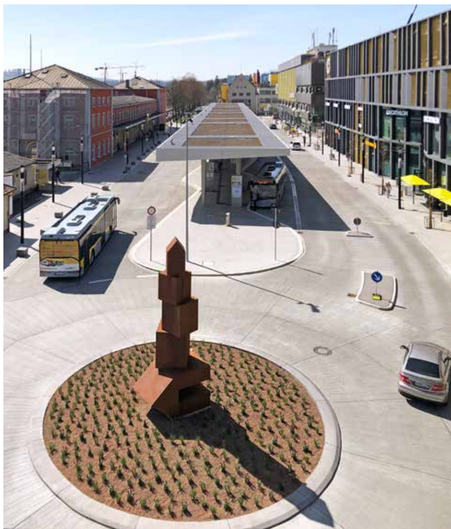
A korszerű útéptés jó példája a tartós betonburkolat alkalmazása: az igen nagyforgalmú singeni (Németország) autóbuszpályaudvar betonja legalább 30 éves élettartamot biztosít.
