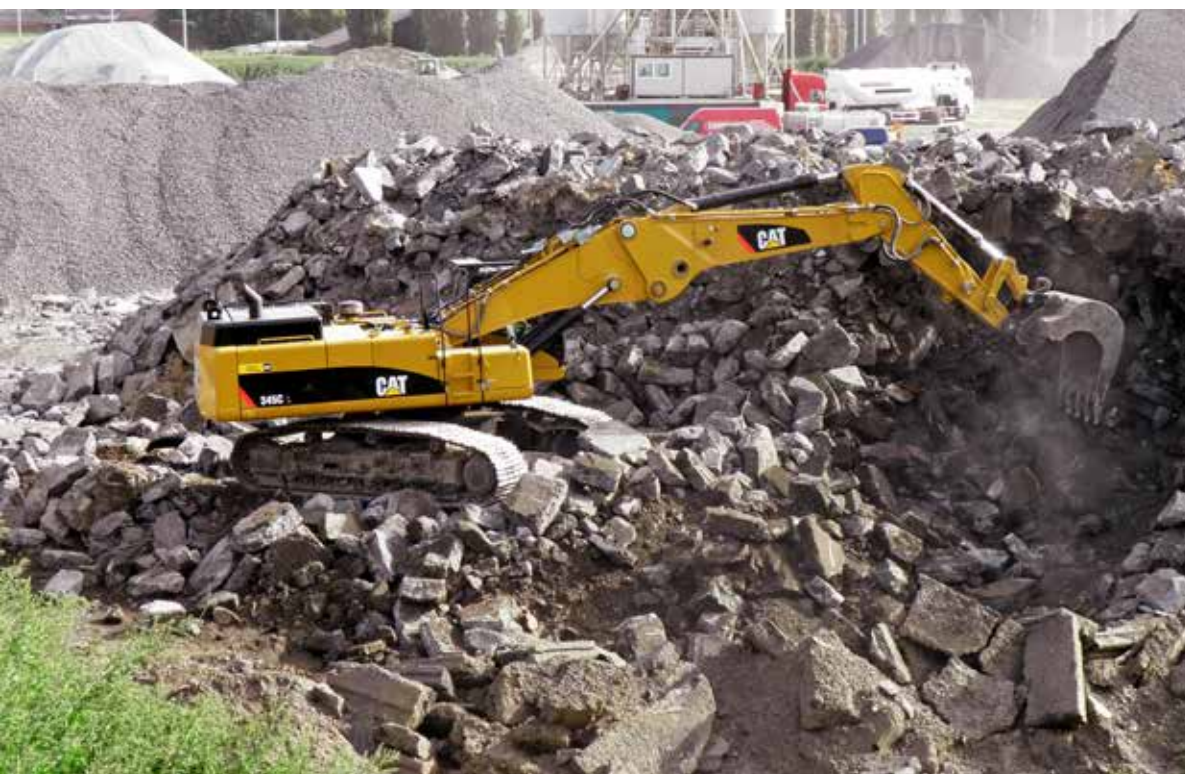
A beton „okos” törése/aprítása miatt az újrahasznosított bontalék minősége javul és a különválasztott cementkő is újrahasznosítható
