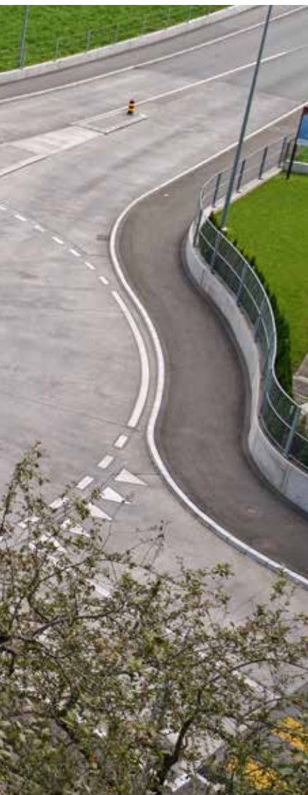
Az első svájci körforgalom zajcsökkentő és érdes mosottbeton felülettel Uri Kantonban, Altdorfnál.
